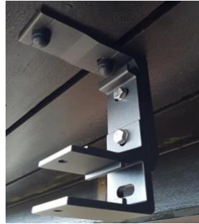
Veggbrakett montert mot takbrakett
